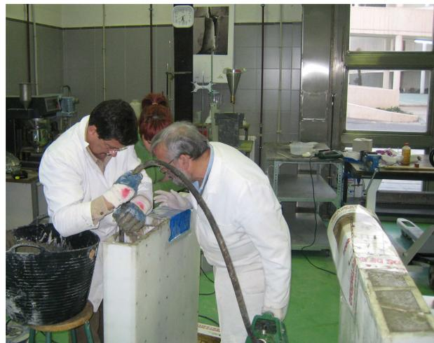
**Fig. 69:** Llenado de los moldes de hormigón vibrado
